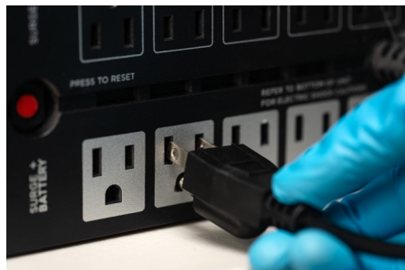
Figura 5. Energizar de la campana
